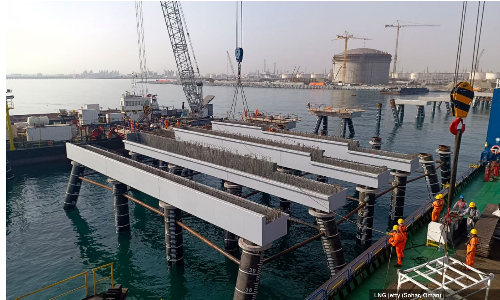
LNG jetty (Sohar, Oman)
