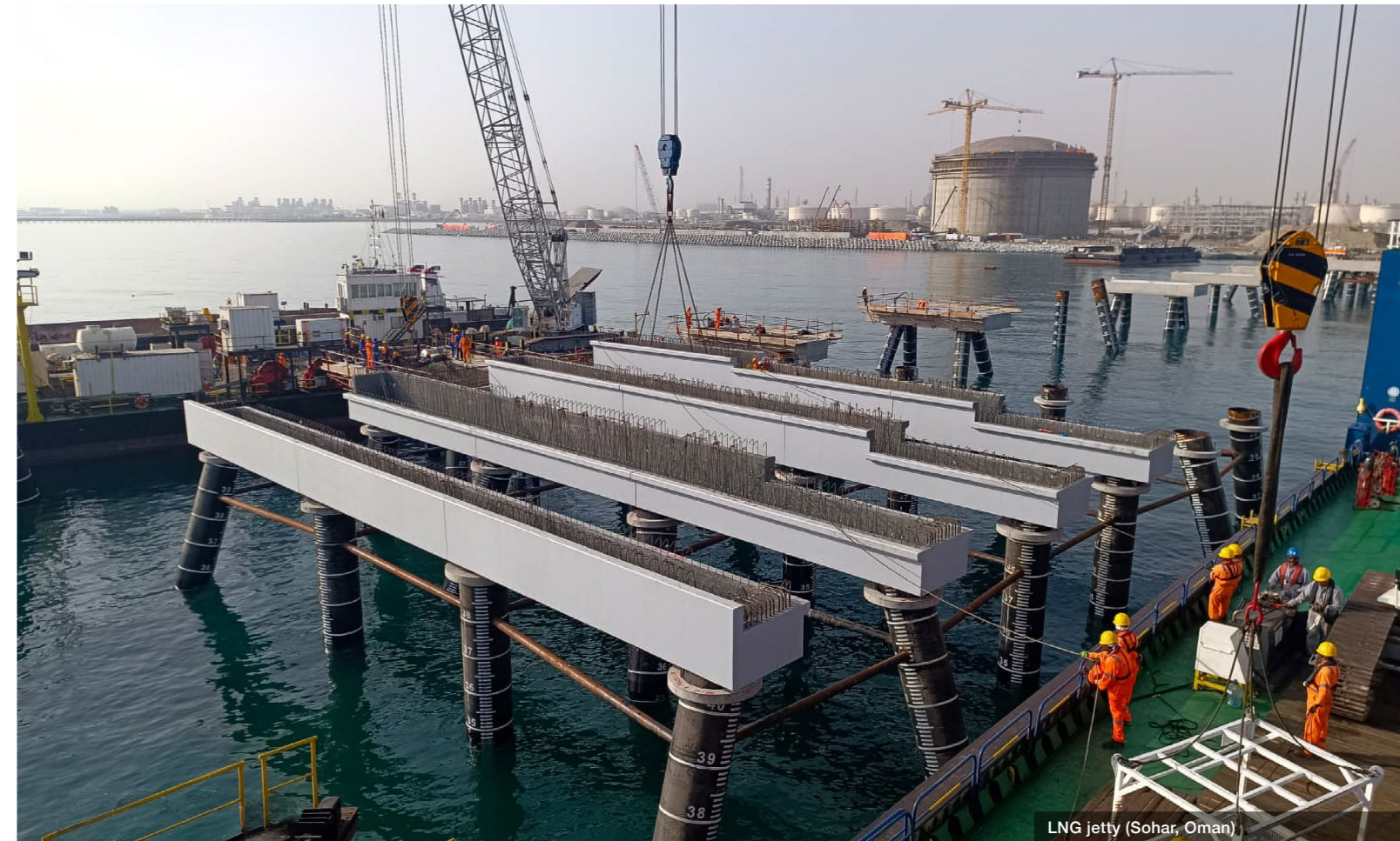
LNG jetty (Sohar, Oman)
